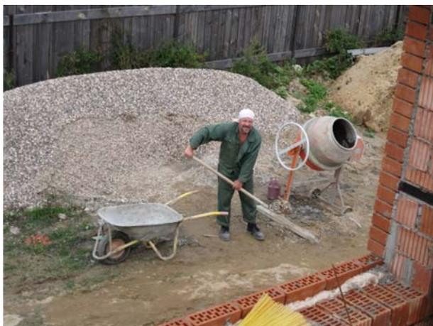
Один из наиболее важных показателей любой бетономешалки — качество перемешивания раствора. Машина оснащена лопастями особой конструкции, обеспечивающими качественное перемешивание. Барабан можно установить под разным углом наклона к вертикальной плоскости, регулируя его положение при помощи колеса управления.
