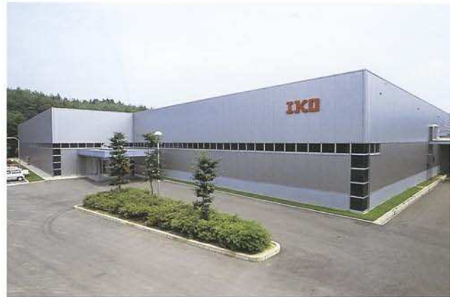
Производственная площадка в Гифу № 3
