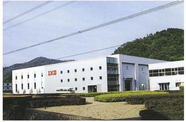
Производственная площадка в Гифу № 2
